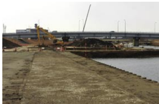
拡幅護岸工事中の梯川
